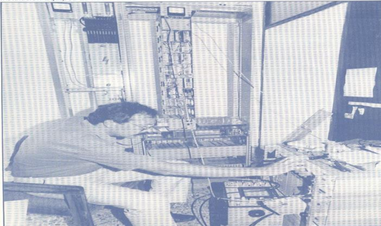
Instalación Equipos de Micro-ondas
